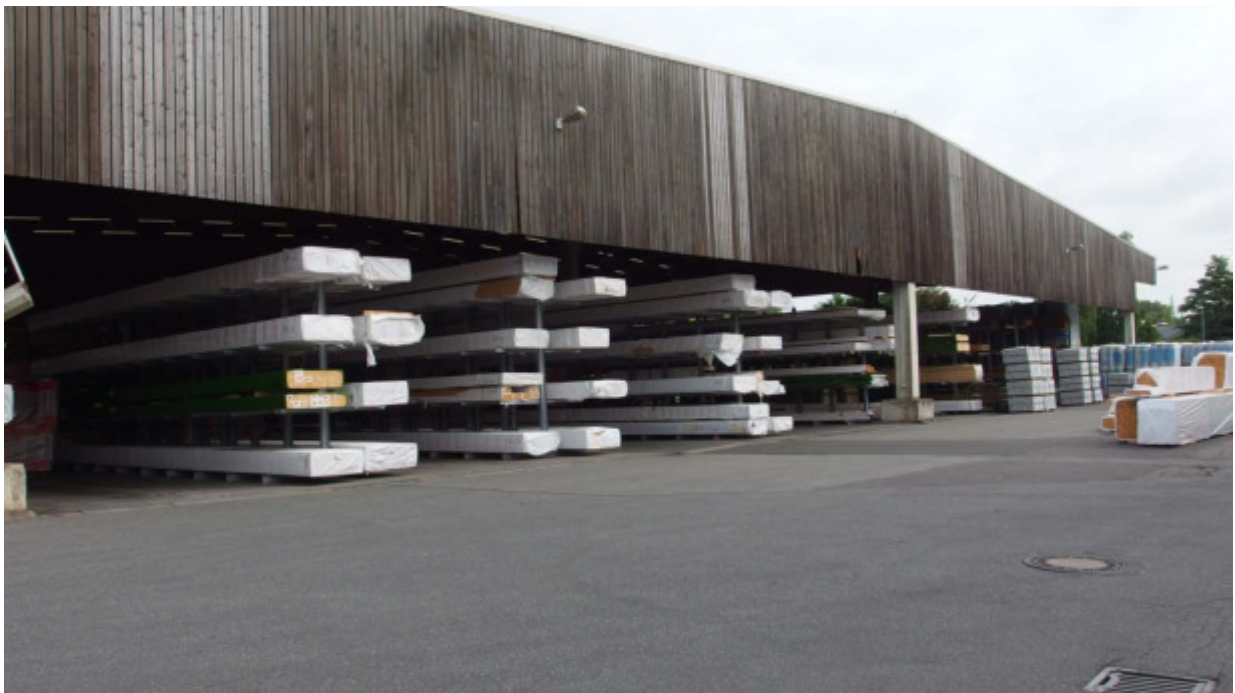
Abb. 2: Blick nach Nordosten auf die Lagerhalle für Holzzuschnitt
