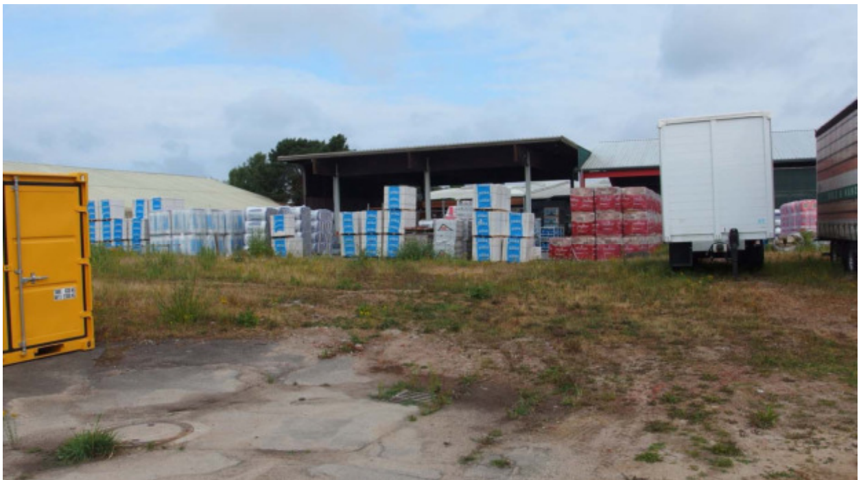
Abb. 8: Blick nach Norden auf die Überdachung der ehemaligen Trockenkammer (Nr. 25 Ergebnisplan). Im Vordergrund die freie Fläche, auf der sich das Hobel- und Sägewerk (Nr. 4 Ergebnisplan) befand.
