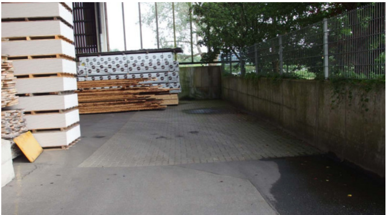
Abb. 4: Blick nach Norden auf den Standort des oberirdischen Tauchbeckens (Fläche ca. 4 m x 15 m) zum Imprägnieren von Holz (Nr. 24 im Ergebnisplan).
