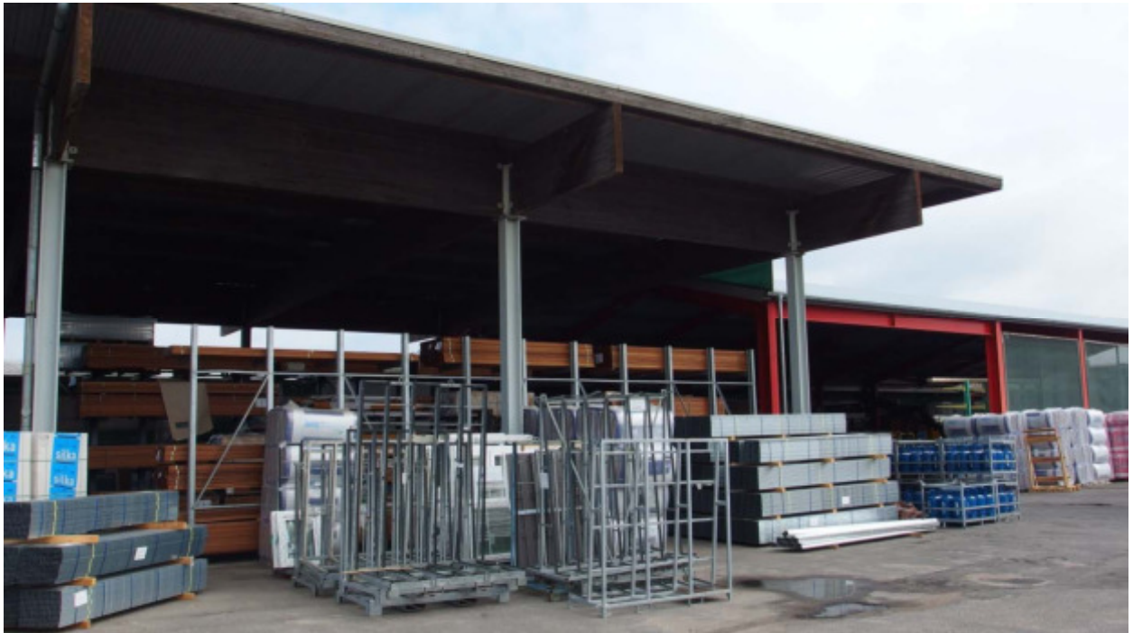
Abb. 9: Blick nach Nordosten auf den Bereich der ehemaligen Trockenkammer (Nr. 25 Ergebnisplan).
